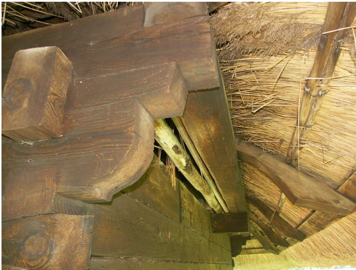
Suszarnia z Pempen, przykład konstrukcji dachu z wysuniętym okapem
