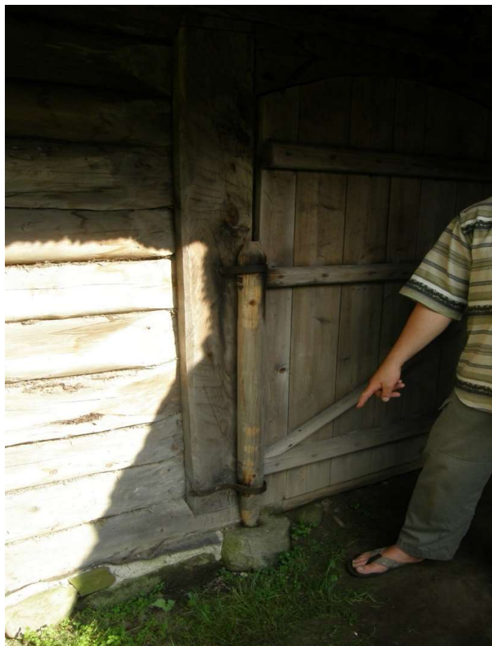
Widok na detal osadzenia wrót, oryginalny kamień zachował się za chałupą z Pempen
