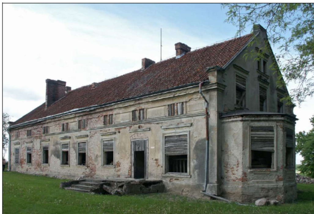
Widok od południowego-wschodu, stan z 2006 r.
