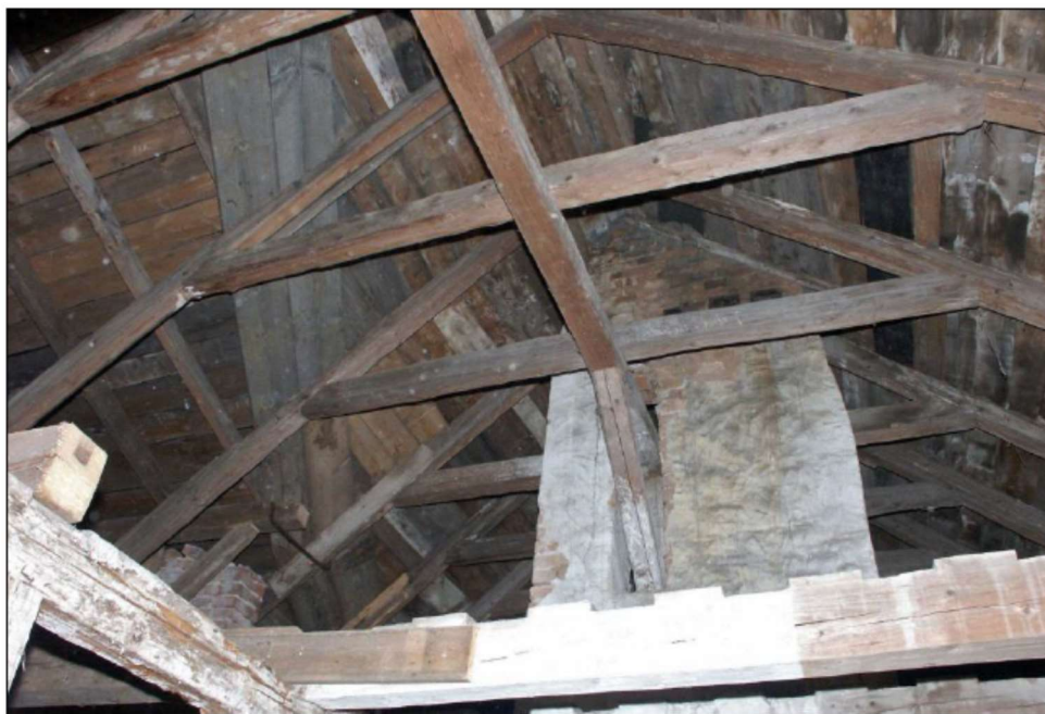
Poddasze, więźba dachowa, widok na część centralną z dachem pseudoryzalitu frontowego, stan z 2006 r.
