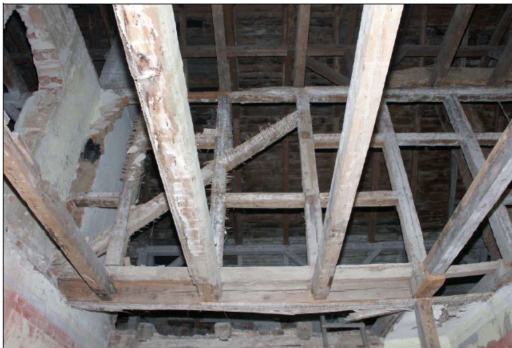
Parter, hall, widok na strop i więźbę, stan z 2006 r.
