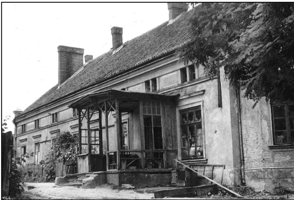
Widok od południowego-wschodu, stan z 1967 r.
