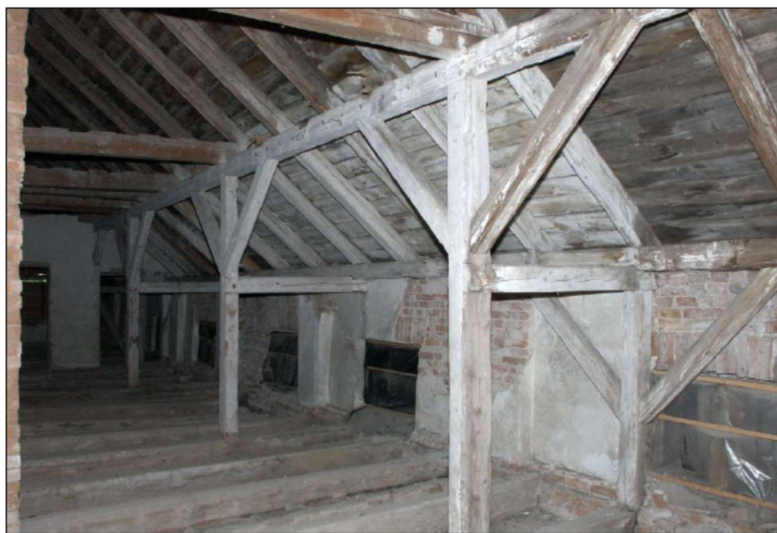
Poddasze, widok w kierunku elewacji ogrodowej, ścianka kolankowa i rama stolcowa, stan z 2006 r.
