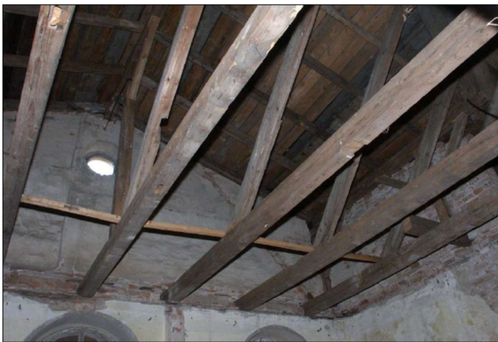
Poddasze, więźba dachowa pseudoryzalitu frontowego, stan z 2006 r.
