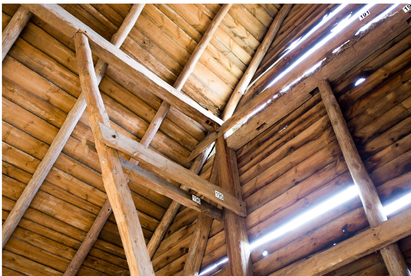
Fot.15. Wnętrze – ściana zachodnia.
