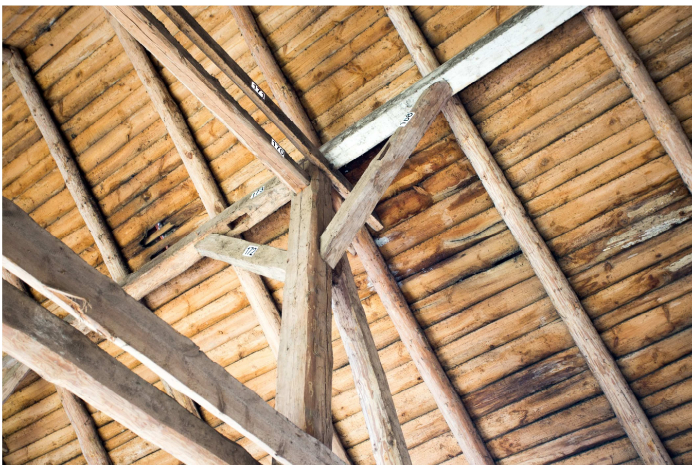
Fot.33. Wnętrze – strona północna – słup D12.
