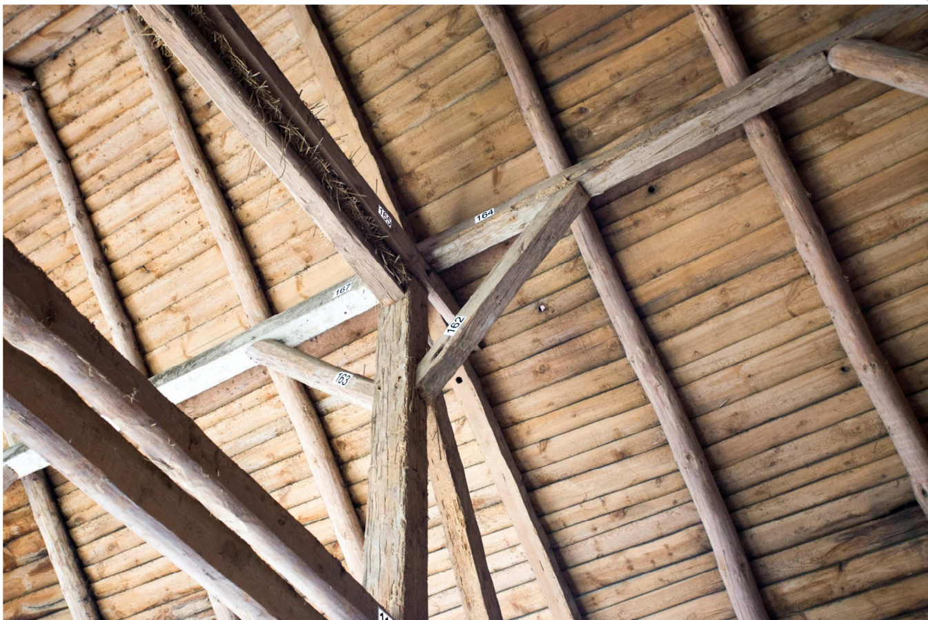
Fot.32. Wnętrze – strona północna – słup D16.
