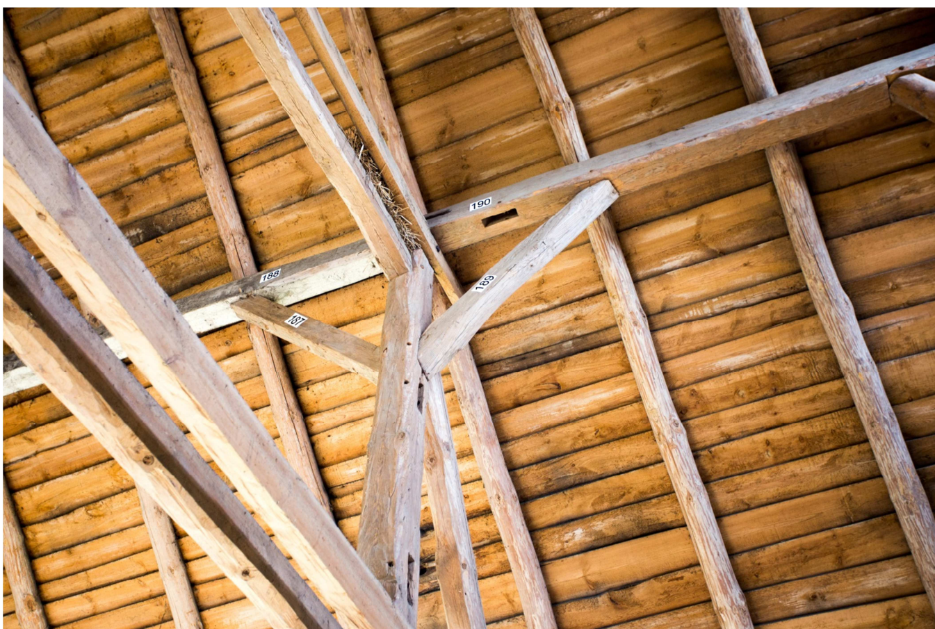
Fot.29. Wnętrze – strona południowa – słup B8.
