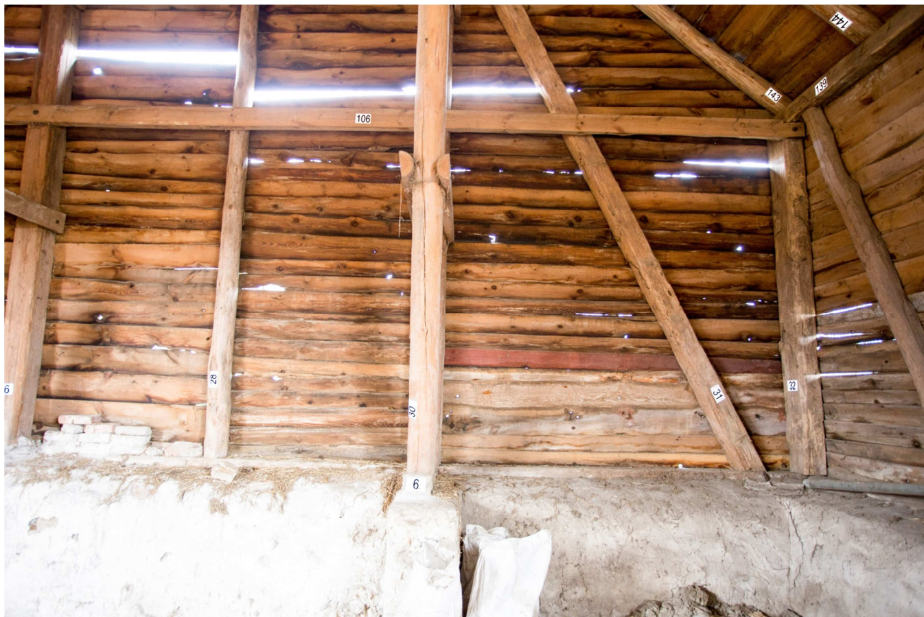
Fot.14. Wnętrze – ściana zachodnia.
