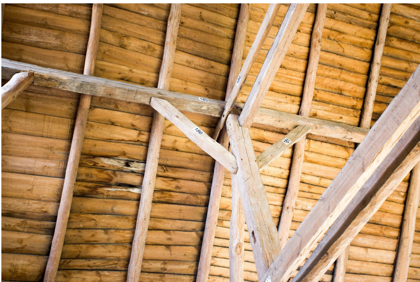
Fot.27. Wnętrze – strona północna – słup D8.
