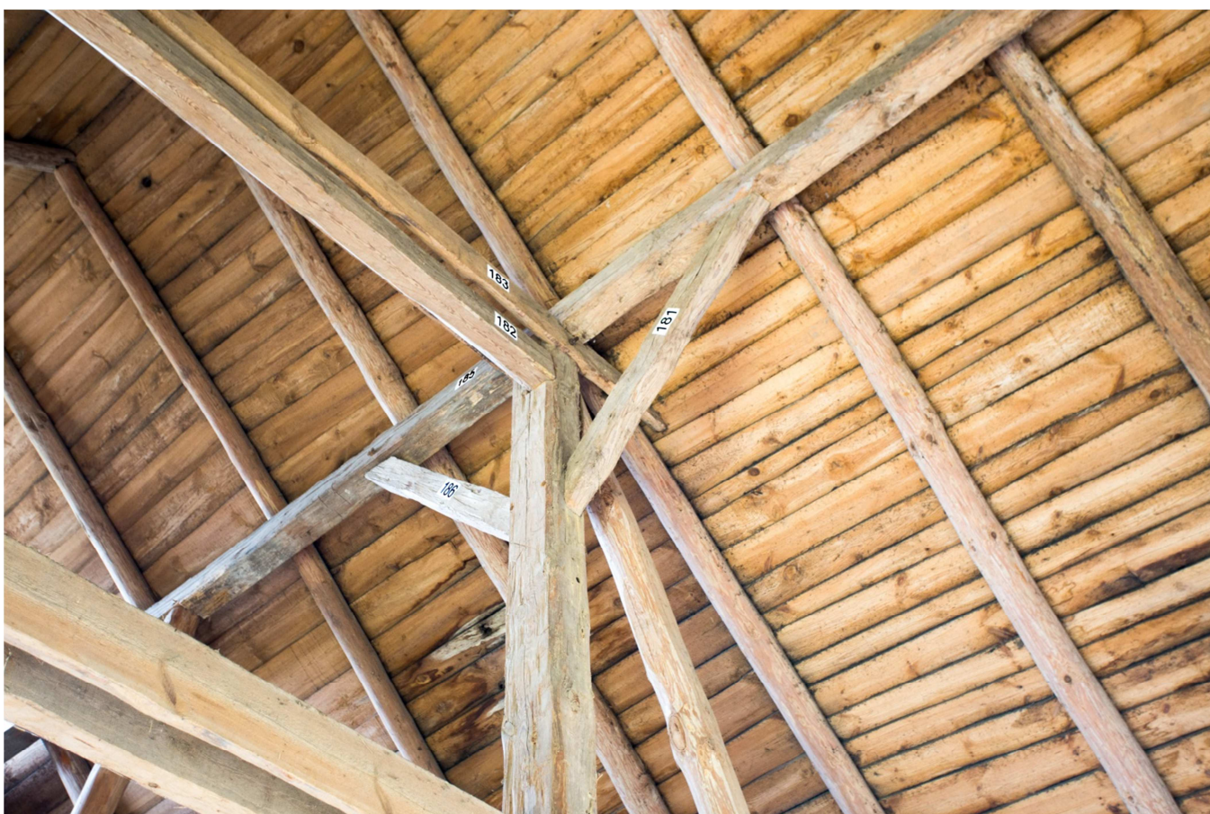
Fot.35. Wnętrze – strona północna – słup D8.
