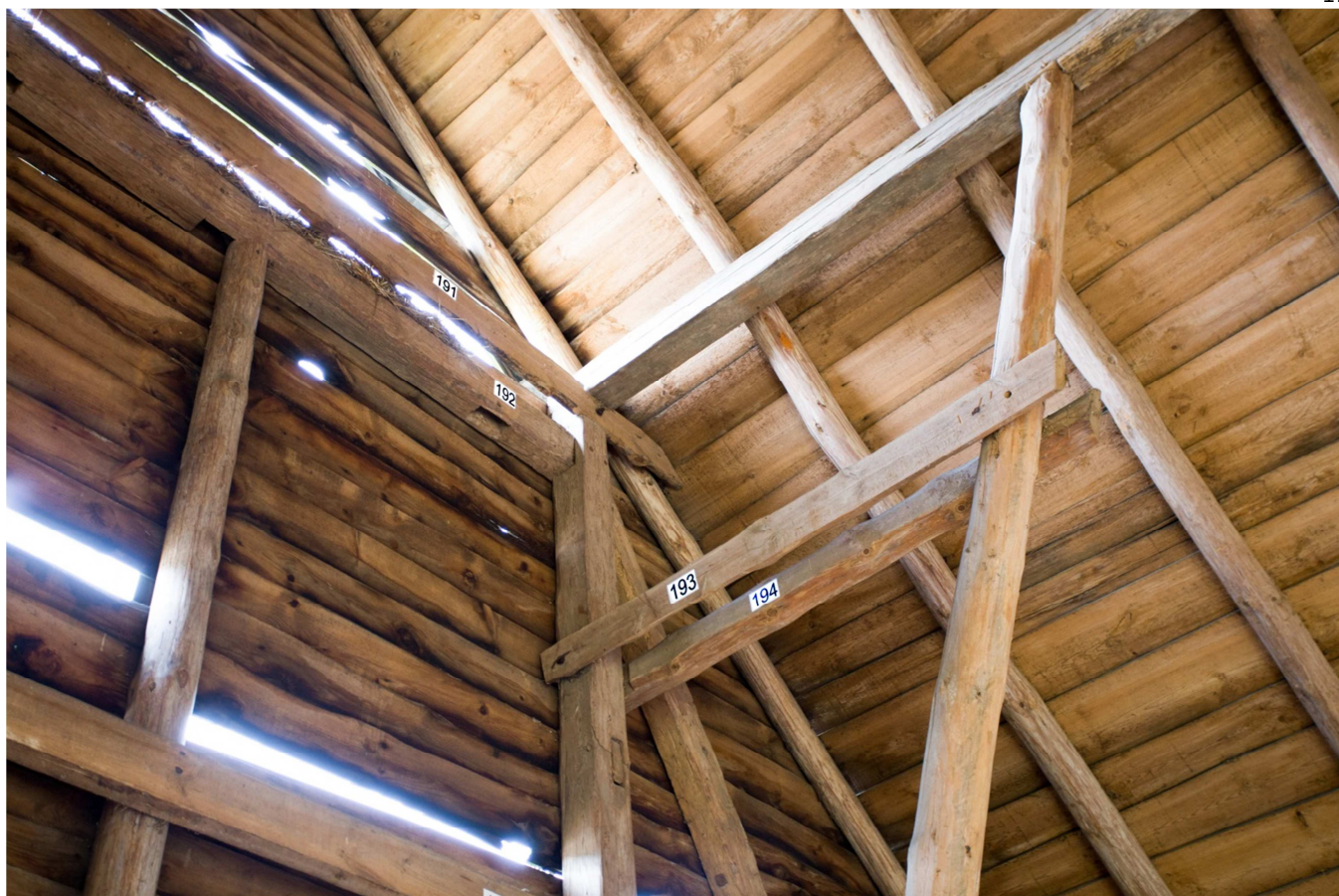
Fot.16. Wnętrze – ściana zachodnia.
