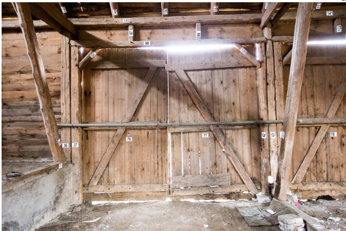
Fot.18. Wnętrze – wrota północne.
