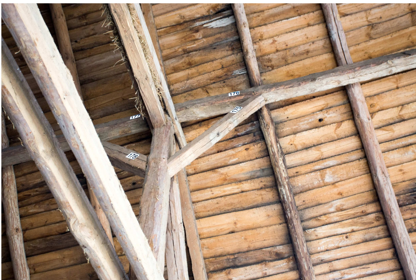
Fot.31. Wnętrze – strona południowa – słup B16.
