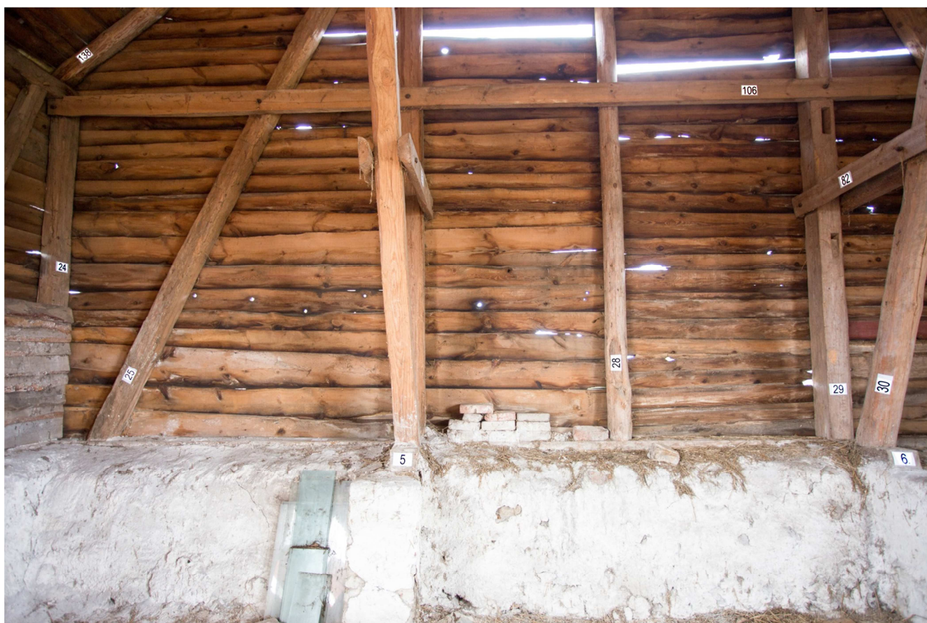
Fot.13. Wnętrze – ściana zachodnia.
