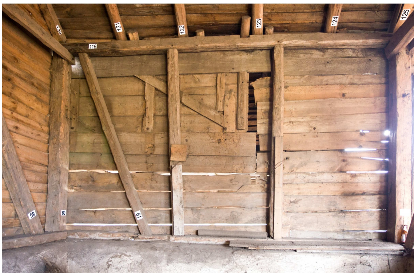
Fot.17. Wnętrze – ściana północna.
