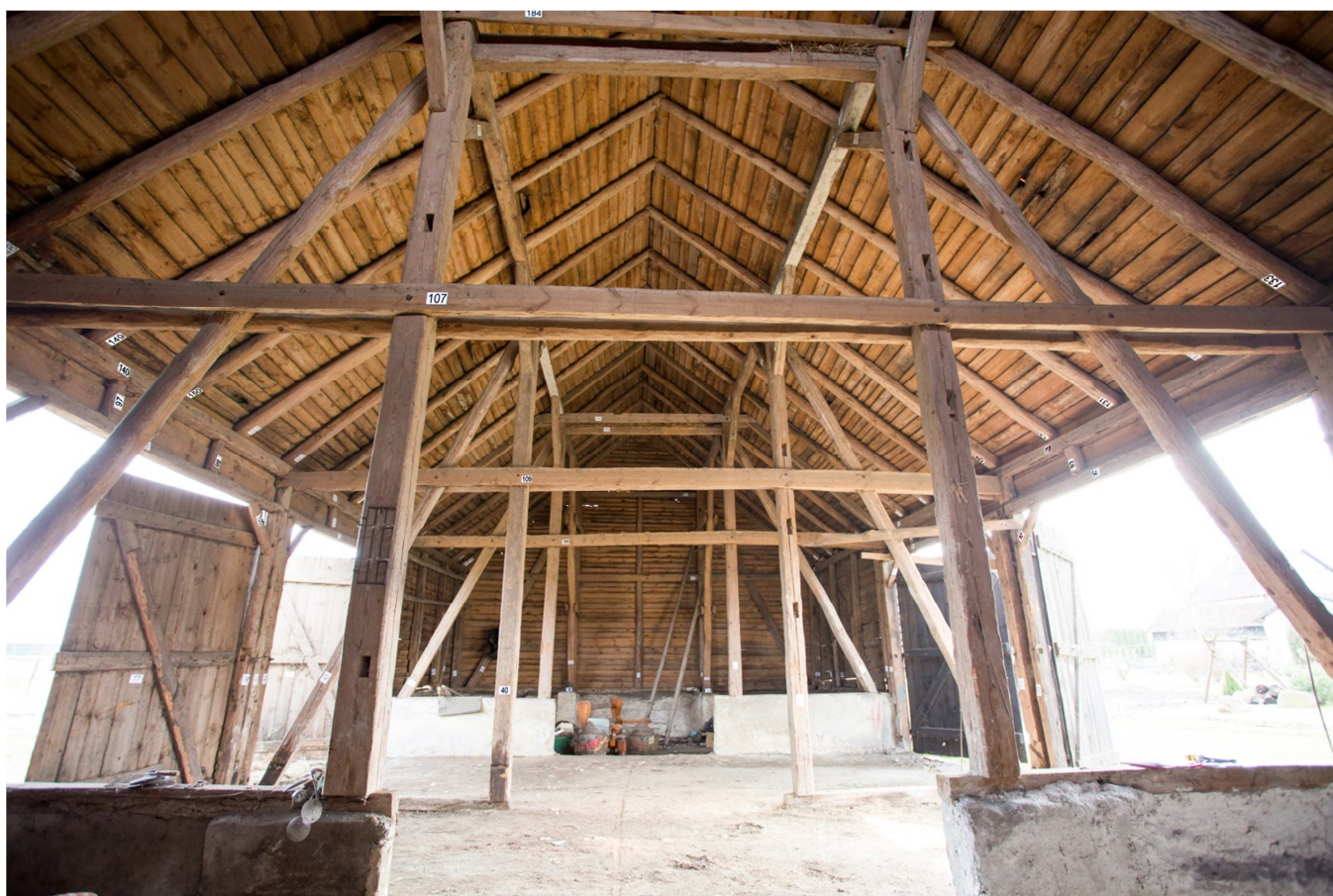
Fot.25. Wnętrze – widok w kierunku wschodnim. Na pierwszym planie rama nr 8.
