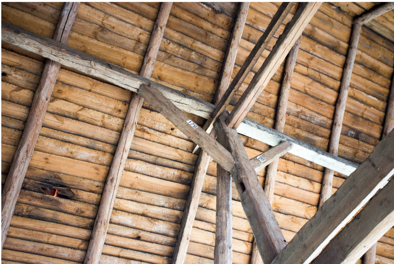
Fot.30. Wnętrze – strona południowa – słup B12.
