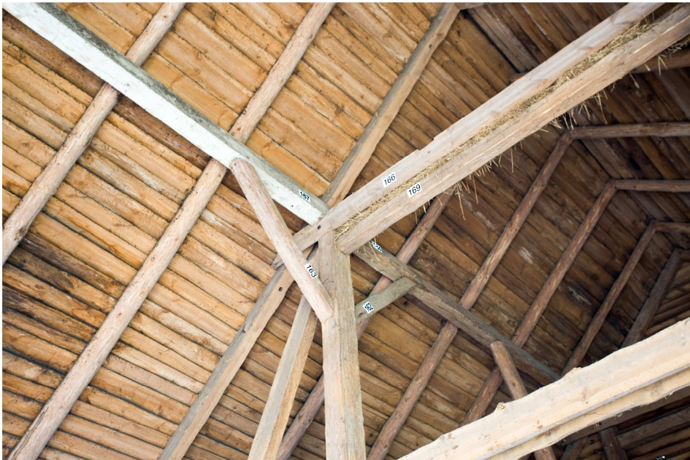
Fot.34. Wnętrze – strona północna – słup D16.
