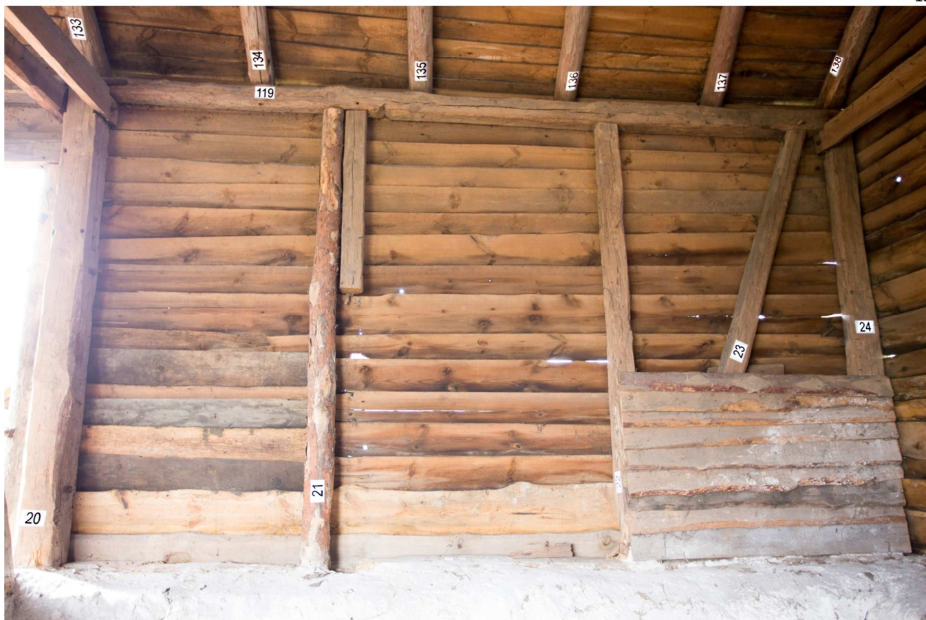
Fot.12. Wnętrze – ściana południowa.
