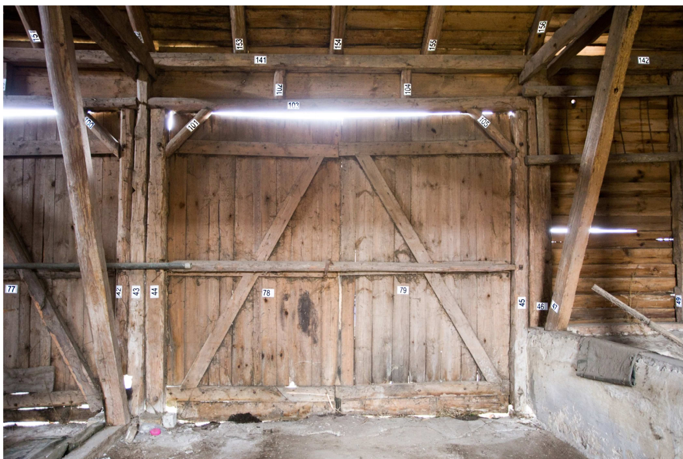
Fot.19. Wnętrze – wrota północne.
