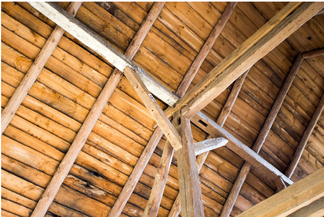
Fot.28. Wnętrze – strona południowa – słup B8.
