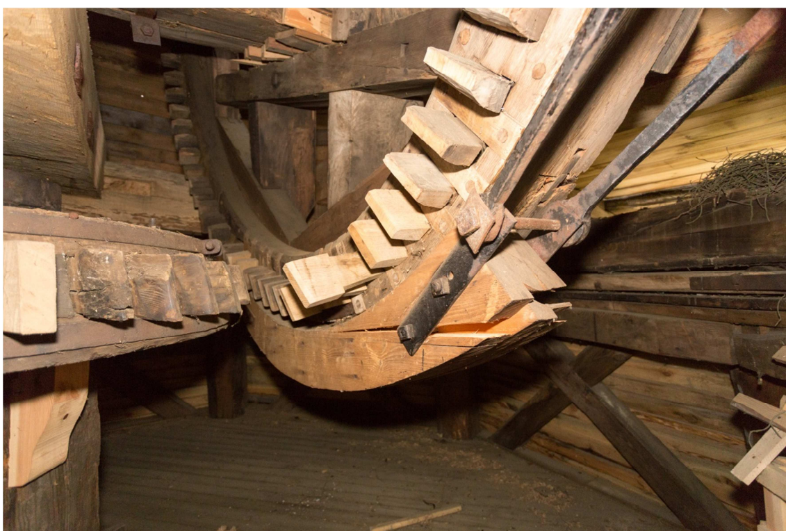
Fot.4. Pęknięty segment hamulca i wypadające nowe zęby koła palecznego.
